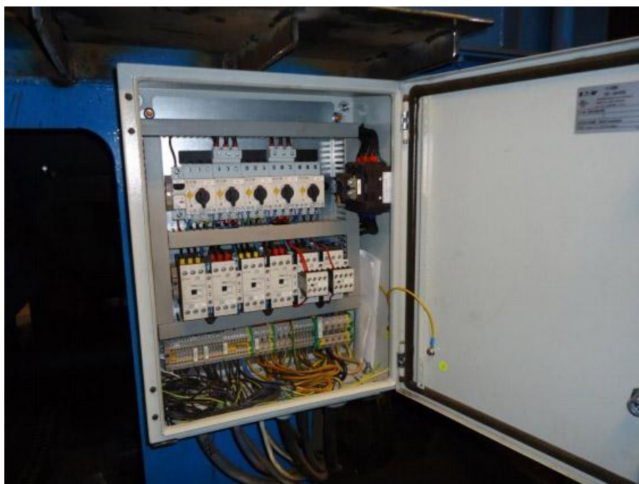
Zdjęcie 12 Szafa sterownicza wozu załadownego
